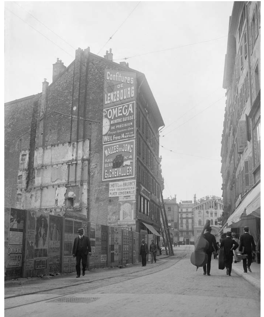
Musiciens devant un chantier à la rue du Rhône n°4-6, 1895-1905, négatif sur verre [BGE CIG FA 875 N]
