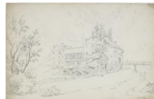
Haute-Savoie, Saint-Gervais-les-Bains: bains Joseph-François Burdallet 15.07.1825
