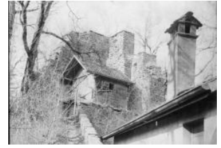
Haute-Savoie, Mornex (mont Gosse): ruines du château 1840-1850
