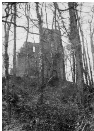
Haute-Savoie, Mornex (mont Gosse): ruines du château 1840-1850
