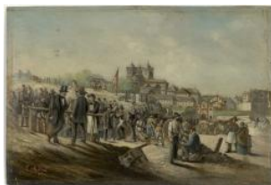
Genève, démolition des fortifications de Rive
