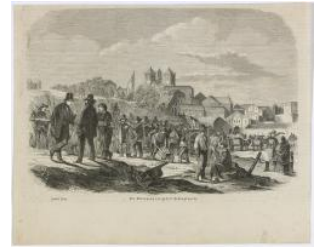
Genève, démolition des fortifications de Rive milieu 19e s.; 1849; 1850
