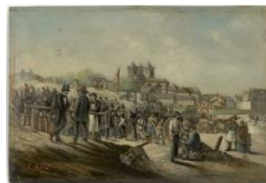
Genève, démolition des fortifications de Rive
