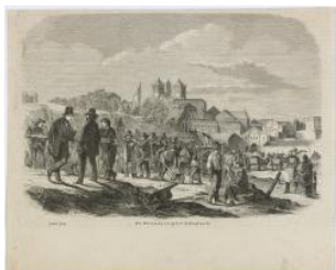
Genève, démolition des fortifications de Rive milieu 19e s.; 1849; 1850
