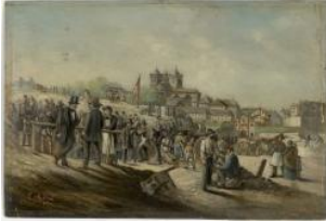
Genève, démolition des fortifications de Rive
