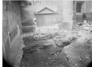
Genève, rue Vallin: redécouverte des restes des victimes genevoise de l'Escalade dans l'ancien cimetière de Saint-Gervais
