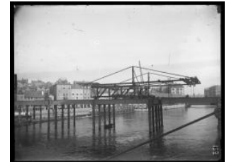
Genève, pont de la Coulouvrenière en chantier Auteur inconnu 4e quart 19e s.
