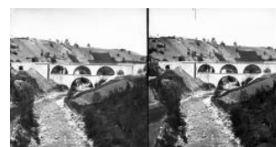
Haute-Savoie, Arthaz-Pont-Notre- Dame: pont sur la Menoge
