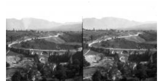
Haute-Savoie, Arthaz-Pont-Notre-Dame: pont sur la Menoge
