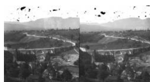
Haute-Savoie, Arthaz-Pont-Notre- Dame: pont sur la Menoge
