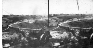
Haute-Savoie, Arthaz-Pont-Notre-Dame: pont sur la Menoge
