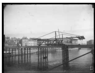
Genève, pont de la Coulouvrenière en chantier
