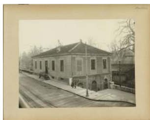
Genève, rue de la Croix-rouge: école primaire Auteur inconnu limite 19e s. 20e s.
