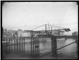
Genève, pont de la Coulouvrenière en chantier Auteur inconnu 4e quart 19e s.
