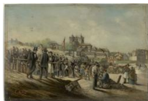
Genève, démolition des fortifications de Rive François Métral après 1849
