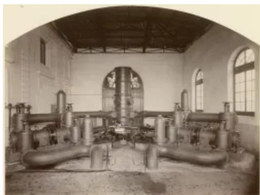
Genève, pont de la Machine: roue-hélice et pompes
