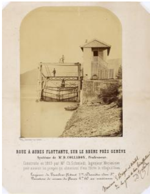
Onex, bords du Rhône: machine hydraulique à roue à aubes flottante alimentant en eau filtrée le village (1865)
