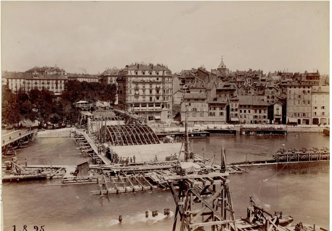
Longtemps, le pont de la Coulouvrenière fut le dernier pont situé en aval sur le Rhône. Construit en 1856-1857 par l'ingénieur polonais Blotzniki afin de relier les boulevards fauzistes des rives droite et gauche, le pont, avec ses fines poutrelles métalliques, n'aurait pu supporter le trafic de l'Exposition nationale de 1896 : il fut donc démolé fin 1894 et remplacé.
